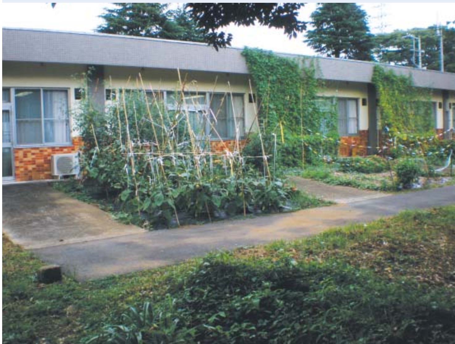
重心病棟 グリーンカーテン
